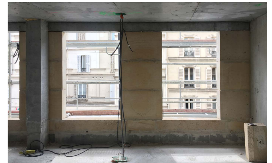
Photo 3 : façade en pierre massive auto-porteuse avec ossature béton poteaux-dalle indépendante
