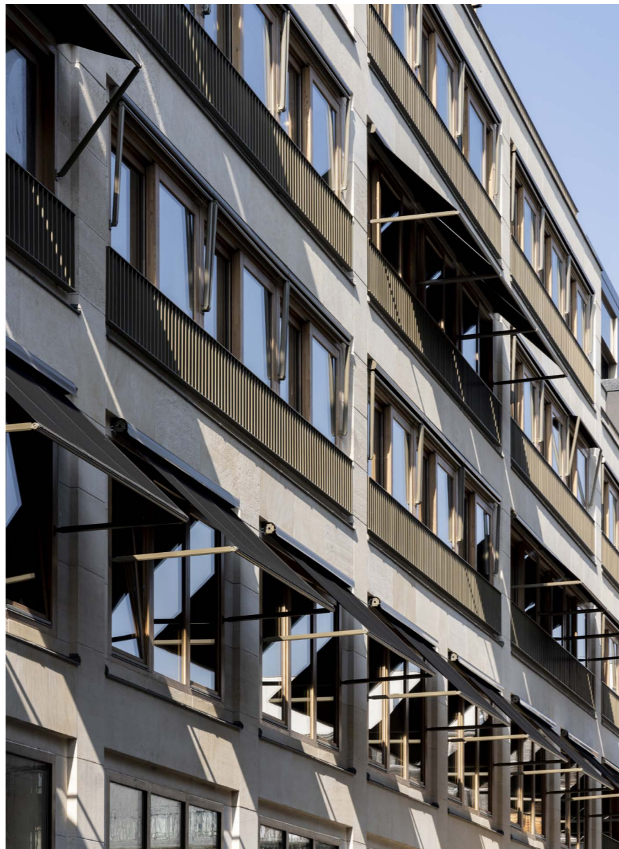
Photo 4 : façade en pierre - stores toile à projections
