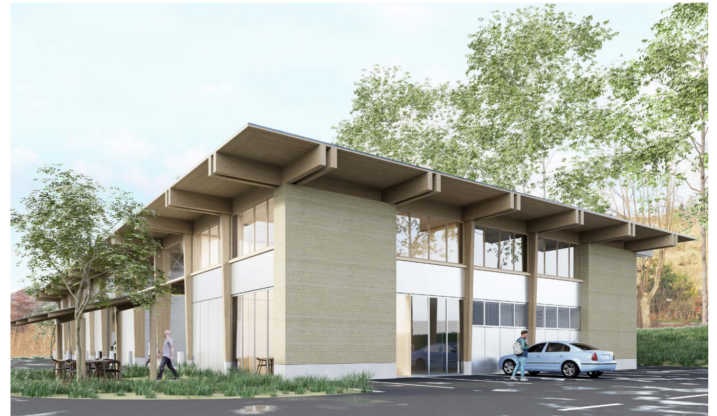
Image 2 : Murs pignons réalisés en terre compactée in situ
