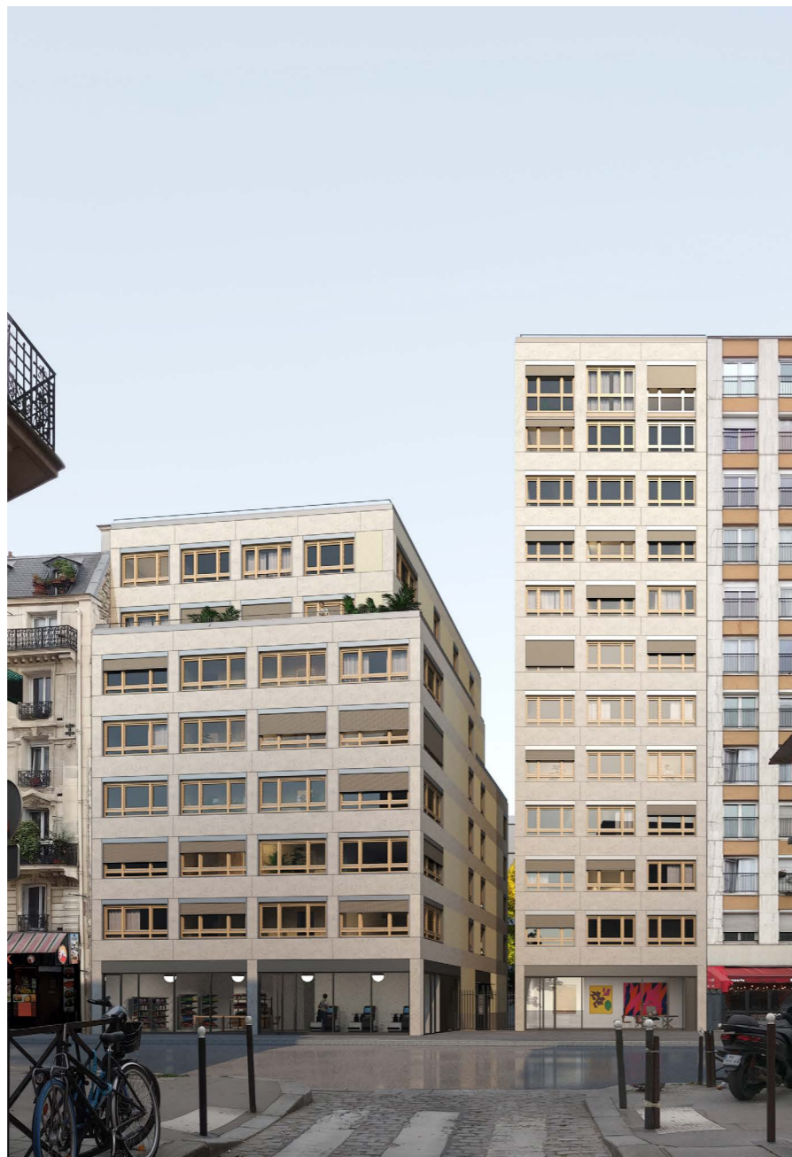
Image 1 : vue depuis la rue la Chapelle - accroche urbaine entre un bâtiment Haussmannien et une tour des années 60
