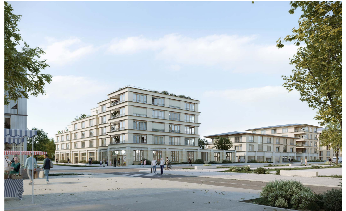
Image 2 : Equipement visible depuis la place du marché dans le socle en pierre.
