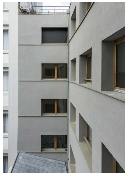
Photo 5 : façades sur cour et stores toile
