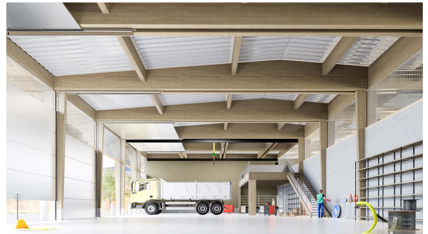
Image 3 : vue intérieure des garages et ateliers - structure et charpente bois
