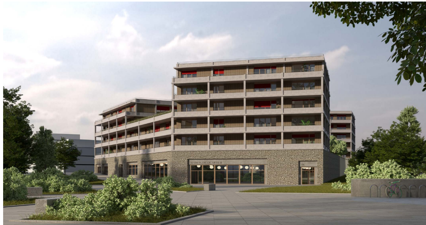
Image 1 : Vue depuis le parvis - larges loggias pour tous les logements
