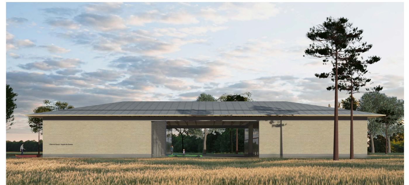
Image : vue depuis le parc des sports - façades en brique de terre crue et charpente en bois
