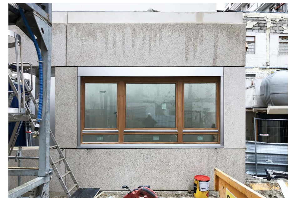
Photo 1 : prototype de façade en béton préfabriqué porteur finition sablé, menuiserie bois et habillage aluminium
